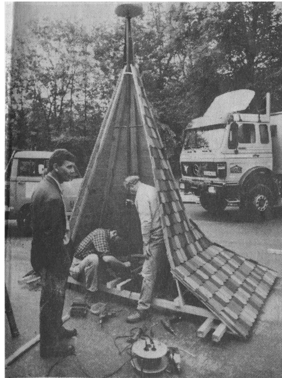
Schlosser Bernhard Maier und Schreiner Walter Wagner geben dem Kirchturmdach den letzten Schliff, ehe es am Haken des Kranwagens über die Wipfel schwebt. Durch die Bäume schimmert bereits der untere Teil des Turms. Fotos: Villarroya
